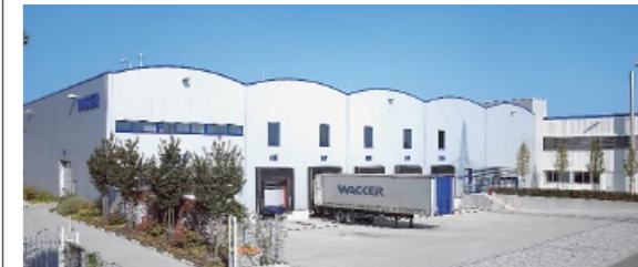
Andock-Terminals für Zulieferungen im Wacker-Zentrallager, Karlsfeld bei München
