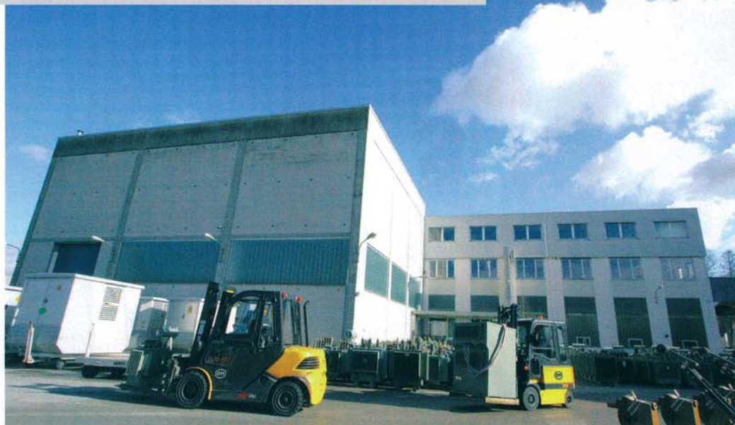
Zu den wichtigsten Betätigungsfeldern der E.ON-Werkstätten gehört die Instandhaltung der Transformatoren.
