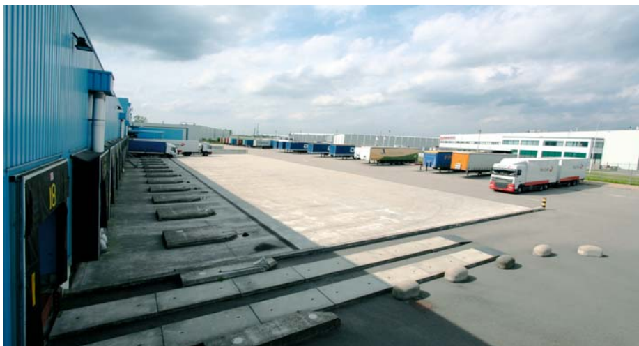
Über den schleusengesicherten DSV-Logistikhof gelangen die LKW zu den Terminals des Hallenkomplexes
