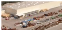
Das neue Zentrallager der Deutschen Steinkohle AG in Marl gewährleistet die effiziente Materialversorgung von sieben modernen Bergwerken.
