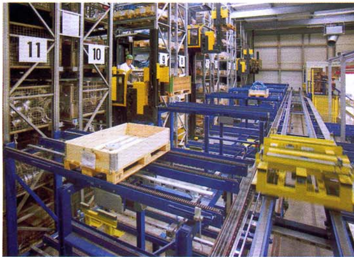
Bereitstell- und Übergabzone für Paletten, die in das Hochregallager eingelagert werden sollen
