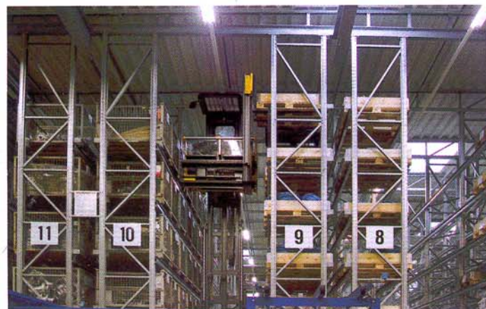
Die Dual-Man-up-Technik bringt die Bediener der Hochregalstapler bei Deutsche Steinkohle AG bis unters Hallendach
