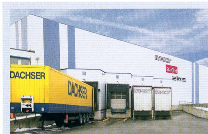
Das Hochregallager mit insgesamt 13 Andockterminals
